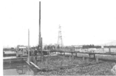
图 7 105# 墩承台正在进行钢板桩插打作业
